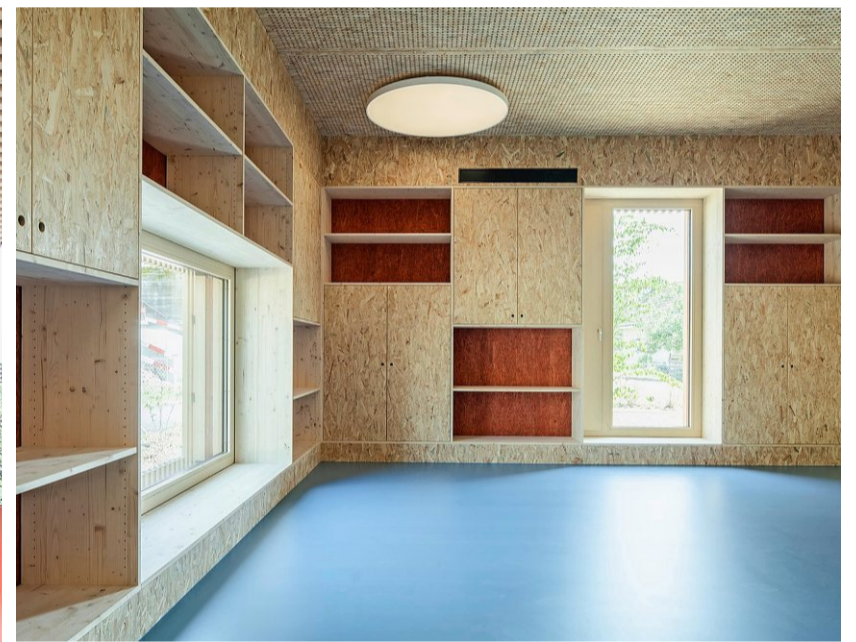
Freundlich und schlicht: Die Fassade ist mit Lamellen aus Weisstanne verkleidet, mit tomatenroten Akzenten. Der gesamte Innenausbau ist mit grob gemaserten OSB-Spanplatten ausgeführt
