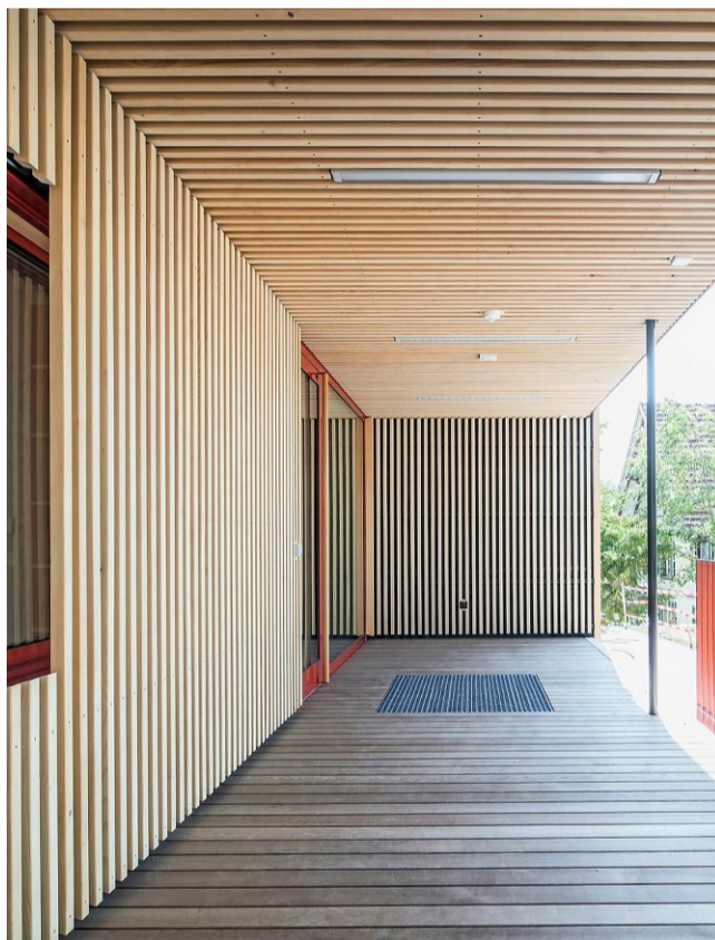
Freundlich und schlicht: Die Fassade ist mit Lamellen aus Weisstanne verkleidet, mit tomatenroten Akzenten. Der gesamte Innenausbau ist mit grob gemaserten OSB-Spanplatten ausgeführt
