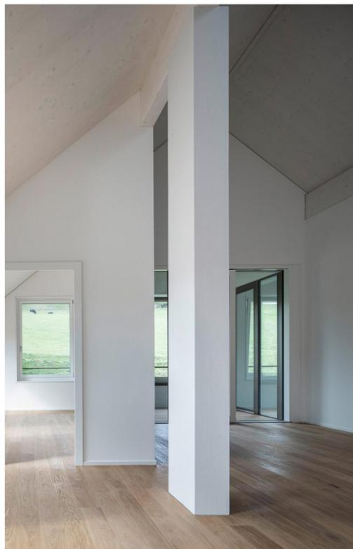
Sichtbarkeit: Die Stützen machen die Konstruktion ablesbar
